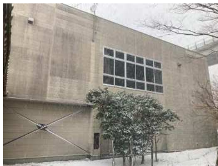
戸賀コミュニティセンター体育館外壁
