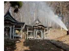
五社堂防災設備点検
