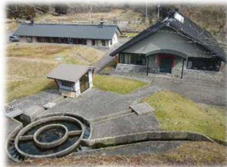
滝の頭水源浄水場
