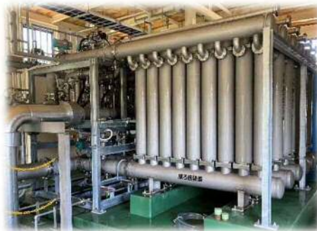
根木浄水場（膜ろ過設備）
