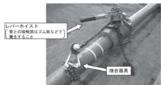
図-4.23 GX型用の器具を用いた接合例2
