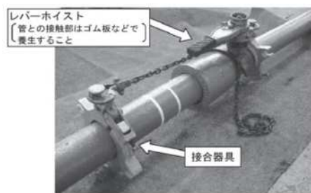
図-4.22 GX型用の器具を用いた接合例
