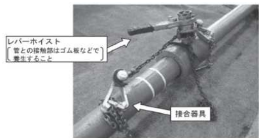
図-4.23 GX型用の器具を用いた接合例2
