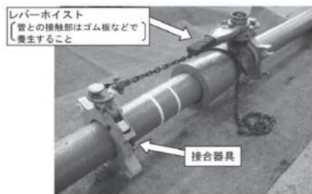
図-4.22 GX型用の器具を用いた接合例
