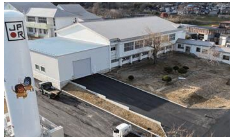
廃校を活用したバックご飯製造工場
