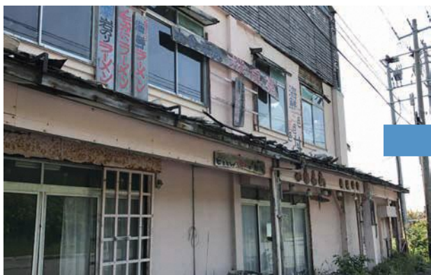
空き家解体実績 旧桜島荘
