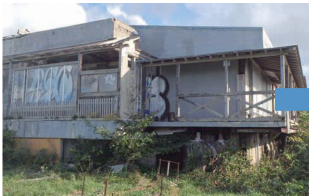
空き家解体実績 八望台ドライブイン
