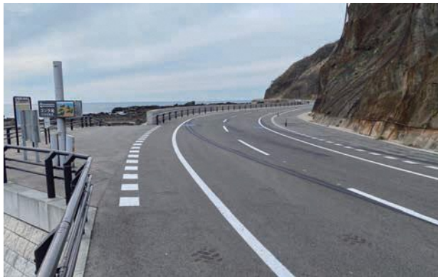
拡幅された県道男鹿半島線（ゴジラ岩前）
