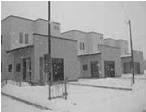
▲平成19年度建設の内子第2団地住宅
