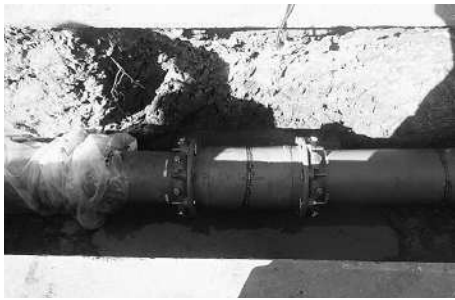
▲耐震管のダクトイル鉄管(GX型)
