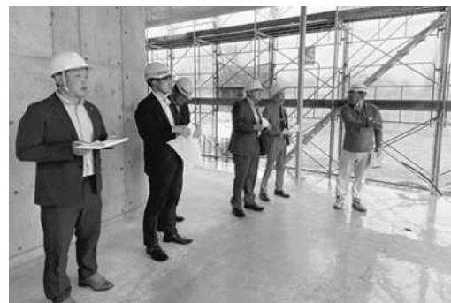
▶ 船越こども園新築工事の進捗状況を確認しました。
