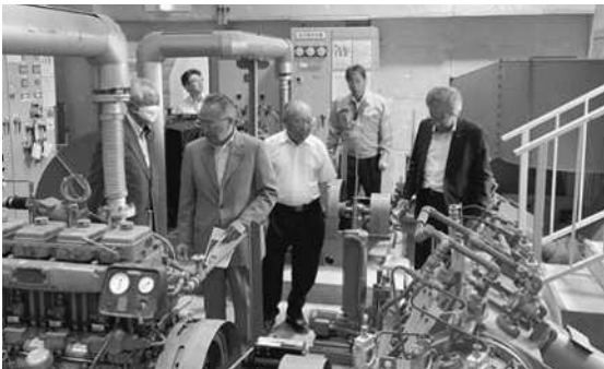
▶ 現地調査を実施し、建物・設備等の劣化状況、改修事業の概要等を確認しました。
