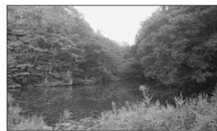
防災重点ため池に指定されている 樋渡沢ため池（北浦安全寺）
