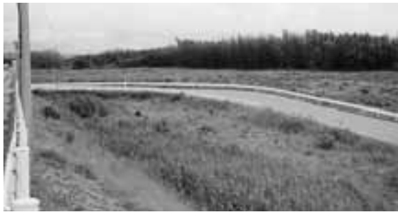
観光案内機能施設用地 ~船越地区男鹿大橋付近~
