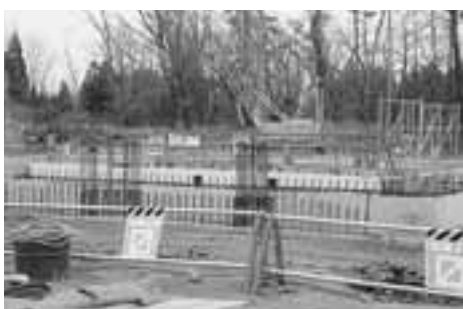
建設中の広域ごみ処理施設
