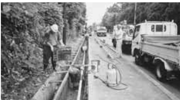
ガス管布設替工事
