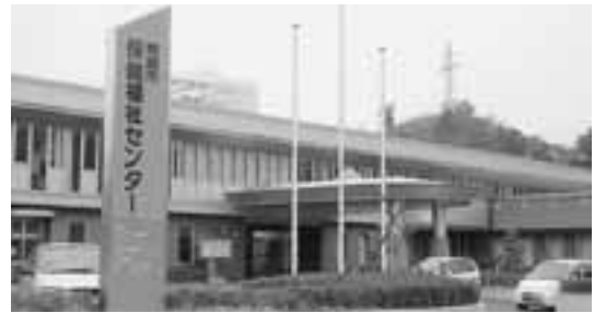
男鹿市保健福祉センター (中央デイサービスセンター)
