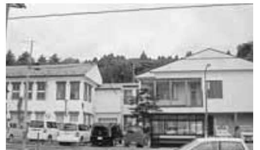
男鹿市役所旧庁舎
