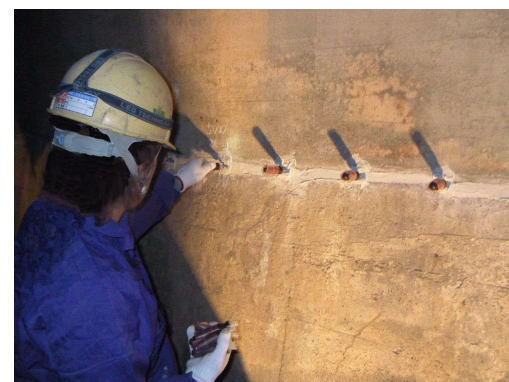
「ひび割れ注入作業状況」
