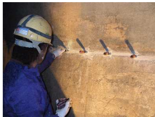
「ひび割れ注入作業状況」
