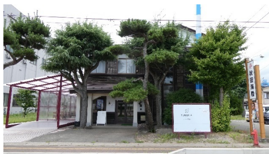
男鹿駅周辺でのリノベーション事例
