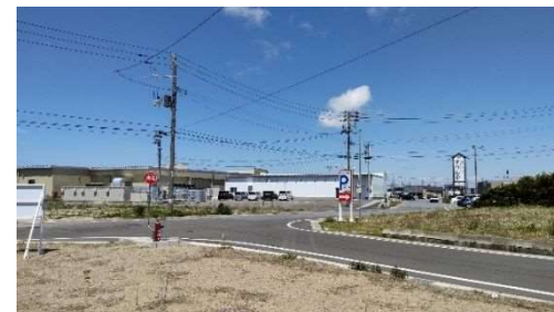
宅地開発により住宅建設が進む
