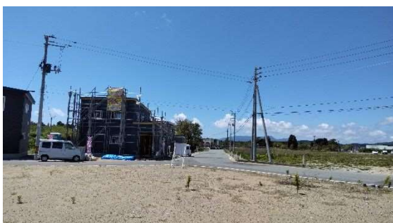
宅地開発により住宅建設が進む（船越地域）
