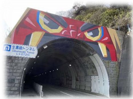
<生鼻崎トンネル>
