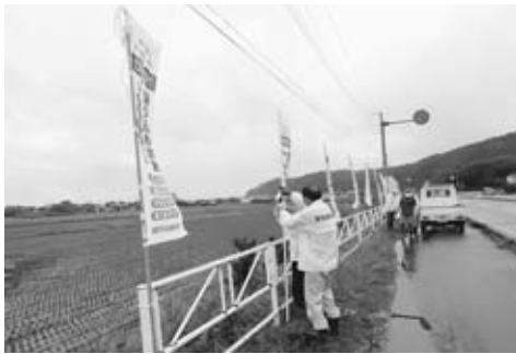
▲雨の中、被害防止の願いを込め防犯旗を設置する会員
