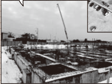
建設地近接撮影
