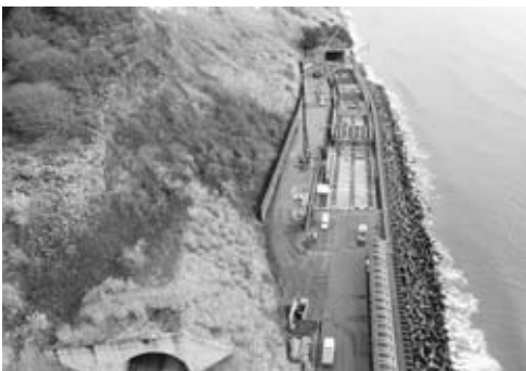
▲工事中の生鼻崎トンネル
