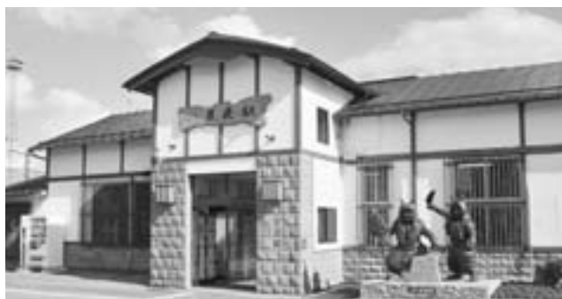
▲築78年を経過した現在の男鹿駅
