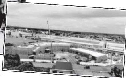
▲コンクリート打設終了後全景
